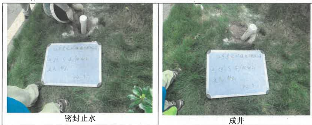
图 6.2-1 土壤钻探和地下水建井过程
