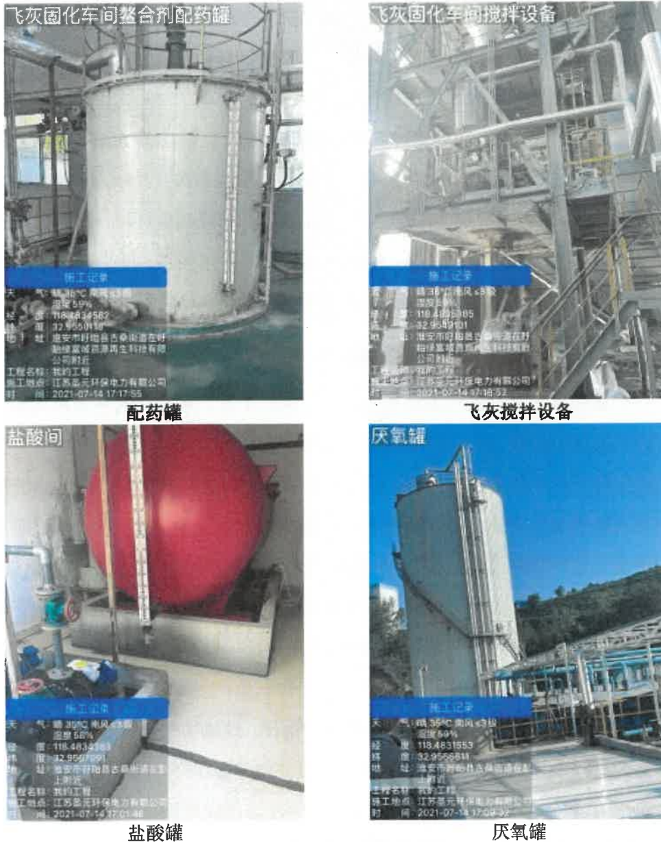
图 4.2-2 现场构筑物照片
