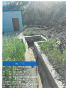
图 4.2-1 地下沟渠现场照片
